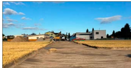
Výstavba nové komunikace v lokalitě Budovatelská a U trati
